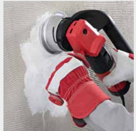
Der Fräskopf mit seinen 12 Hartmetallrädern eignet sich besonders zur Entfernung von altem Fliesenkleber.
