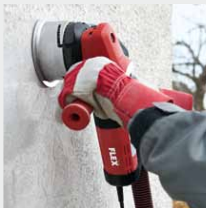
Dank geringem Gewicht und hervorragendem Handling lassen sich mit der RETECFLEX alle Wände hervorragend bearbeiten.
