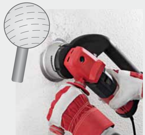
Durch Farbe versiegelte Tapeten werden durch die Schneidräder des neuartigen Perforators geöffnet. Dadurch kann Flüssigkeit (Tapetenlöser) schneller eindringen.
